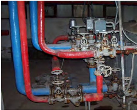
Resim4.14: Merkezi sistem tesisat devresi
