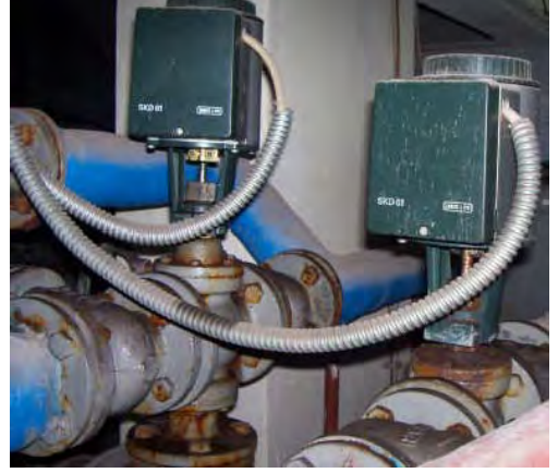
Resim 4.20: Merkezi sistem üç yollu vana montajı
