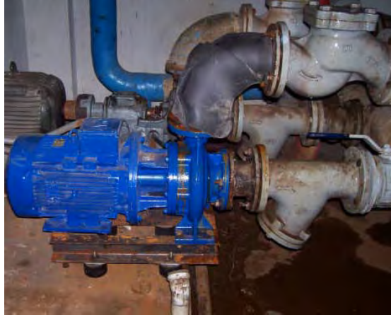
Resim4.28: Santrifüj pompanın tesisata montaj resmi
