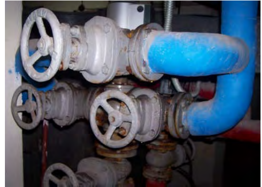
Resim4.15: Merkezi sistem tesisat devresi vana montajı
